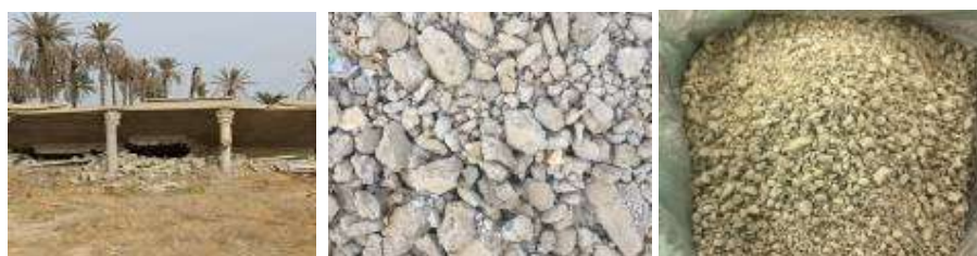
а) разрушенное здания ; б) отходов сноса ; в) бетоны лома
