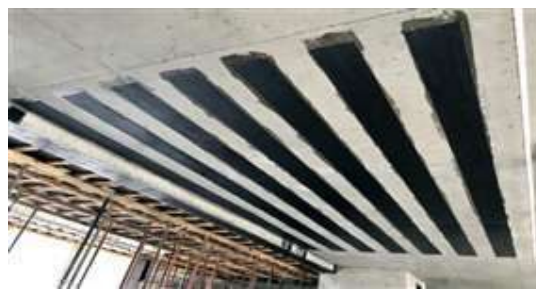
Рис. 4. Усиление бетонных и железобетонных конструкций углеволокном.
