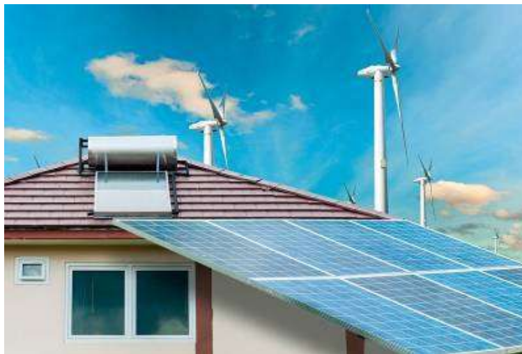
Рис. 1. Солнечные батареи в частном жилом строительстве
