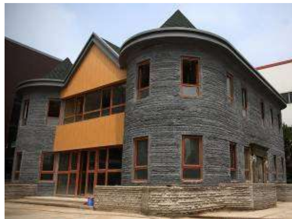
Рисунок 1. Двухэтажный особняк, напечатанный на 3D принтере компанией Huashang Tengda, Китай
