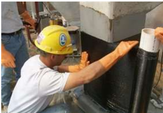
Рис. 3. Усиление бетонных и железобетонных конструкций углеволокном
